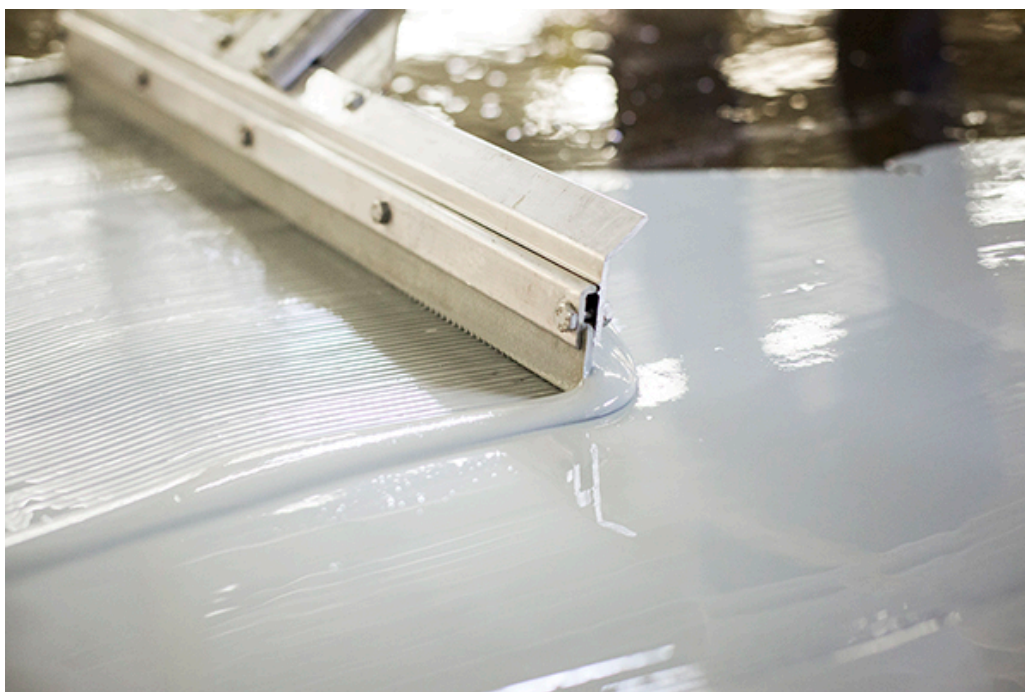
Foto: Aanbrengen vloeistofdicht beschermstelsel.
